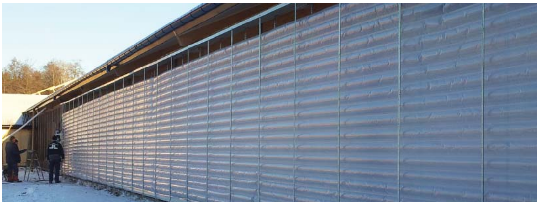
Bilden visar stallbyggnaden under själva byggnationen.
