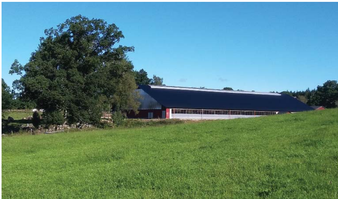
Den färdiga ladugårdsbyggnaden med den flexibla lösningen med väggelement av lumitherm.
